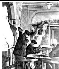
170- Taverne "First and Last Chance" vers 1940 situé sur la rue Saint-Jacques en face de Saint-Rémi. Cet ancien bâtiment a été démoli pour la construction de l'échangeur Turcot (fonds 600 - Jean Leclair).
